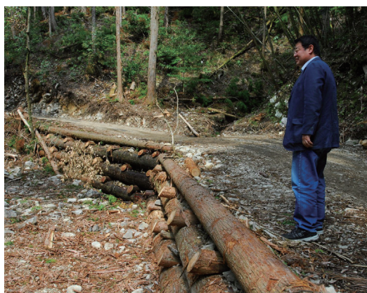
「四十十ハートの森」につくられた四十十式林業作業路
