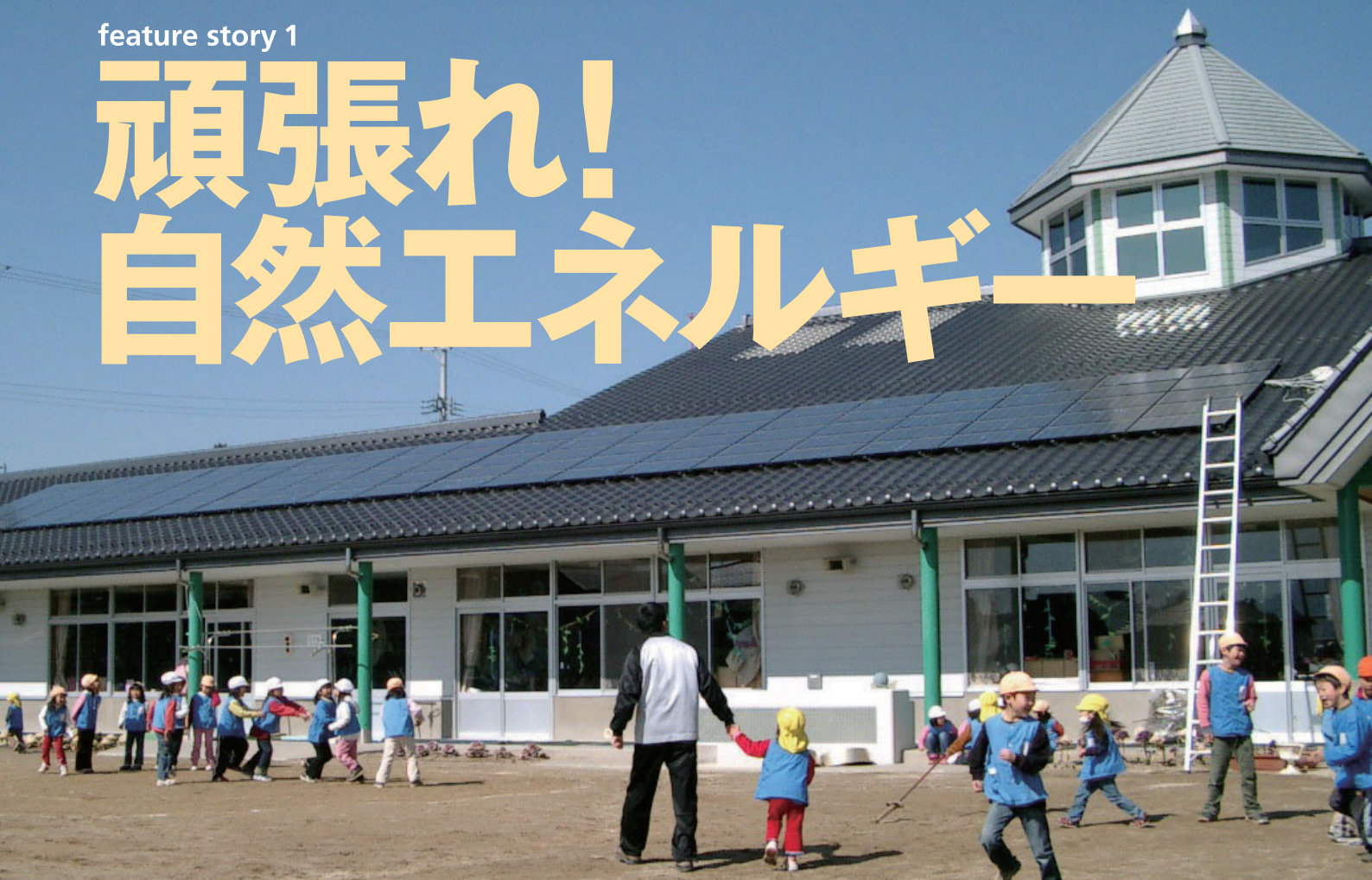
長野県飯田市のおひさま発電所。飯田市立鼎みつば保育園の屋根に設置されている(写真提供 おひさまエネルギーファンド株式会社)
